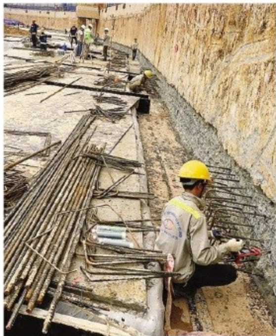
Fissaggio Bossong in un muro di sostegno per renderlo più resistente
