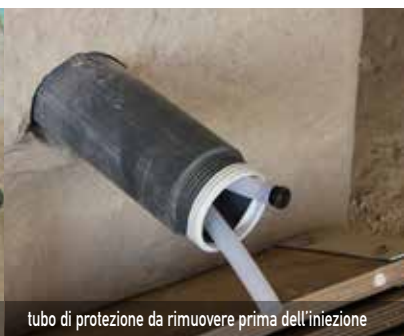
inserimento ancoraggio all'interno del tubo di protezione
