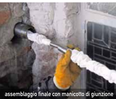
inserimento ancoraggio all'interno del tubo di protezione
