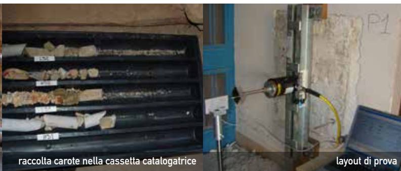
perforazioni per sede ancoraggio test
